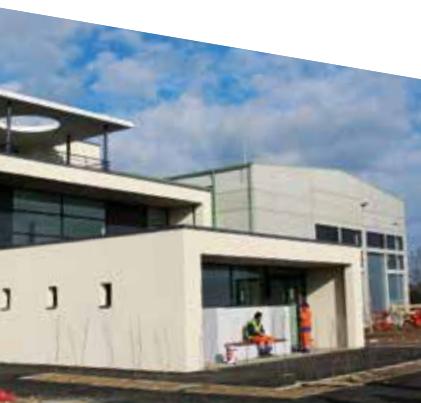
Le nouveau centre de tri de Capvern
